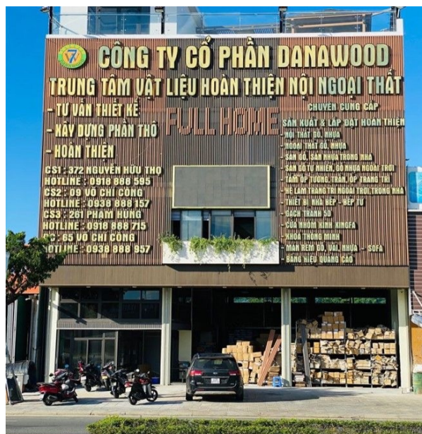
Hình 2.9: Hình ảnh mặt tiền Showroom Danawood tại Võ Chí Công
