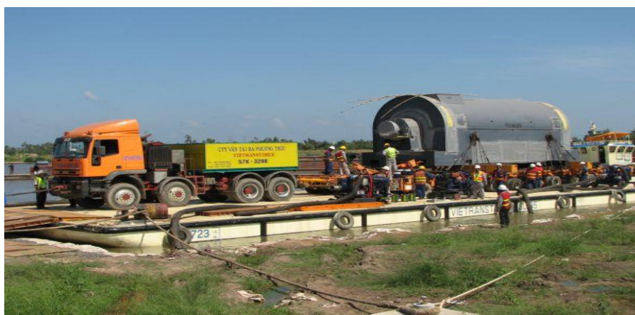
Hình 14. Khảo sát, thiết kế và thi công các bến tạm chuyên dùng phục vụ việc load-in/load-out
