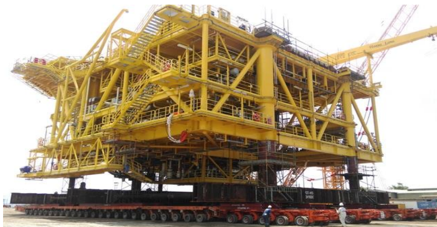
Hình 10. Kết hợp dầm phân tải và hệ thống thủy lực rơ moóc
