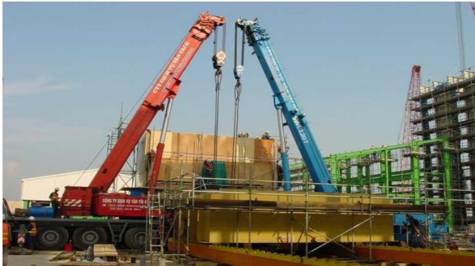
Hình 11. 02 Cần cẩu Bóc xếp, Lắp đặt thiết bị nặng
