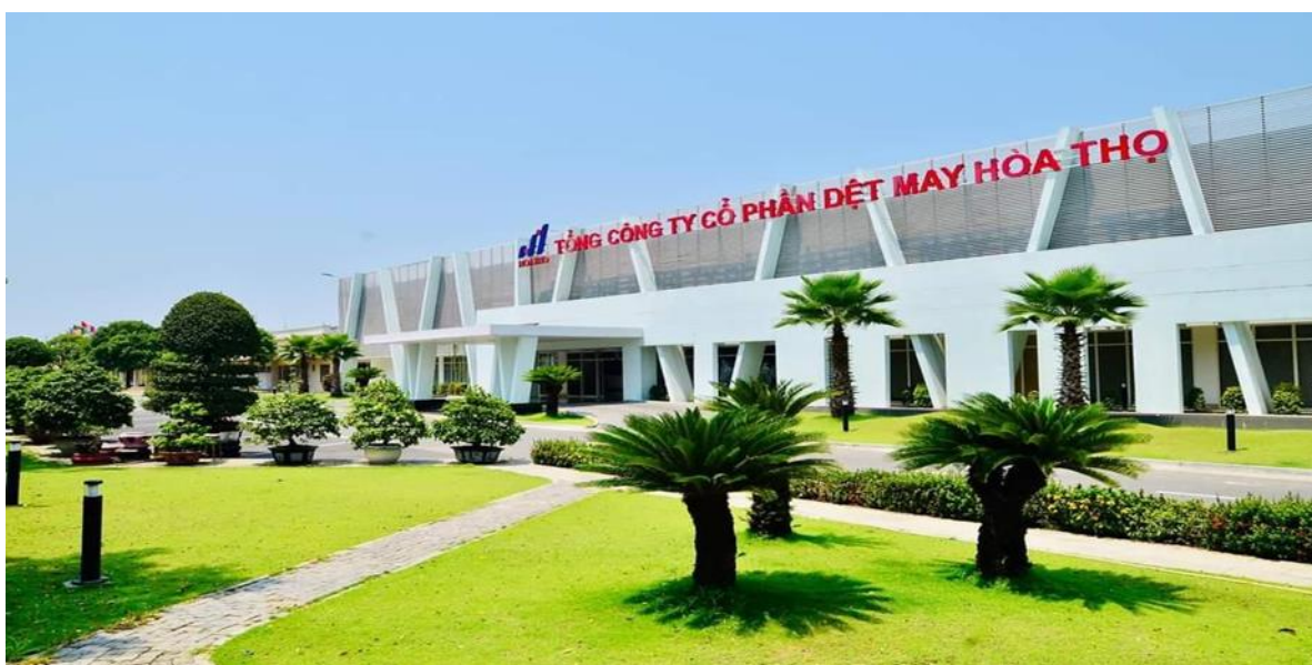
Hình 8: Tổng Công ty Cổ phần Dệt may Hòa Thọ
