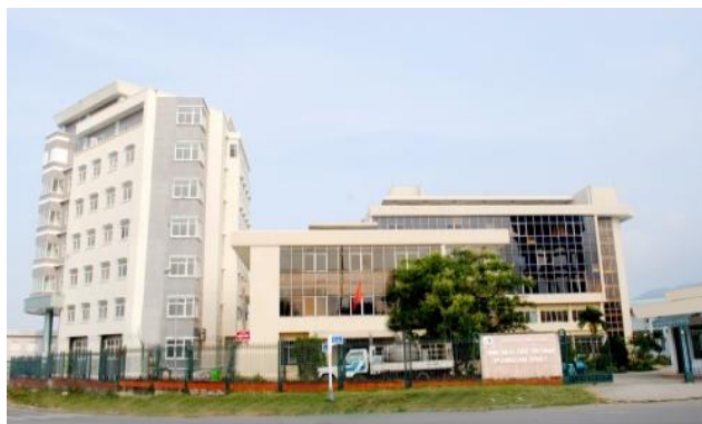
Hình 2.6: Khu đo lường, thử nghiệm tại QUATEST 2
