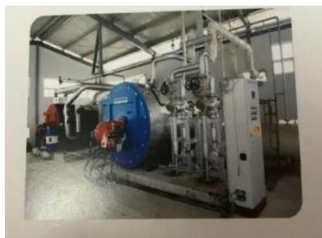
Hình 2.4: Hệ thống gia nhiệt tại kho nhựa đường Thọ Quang
