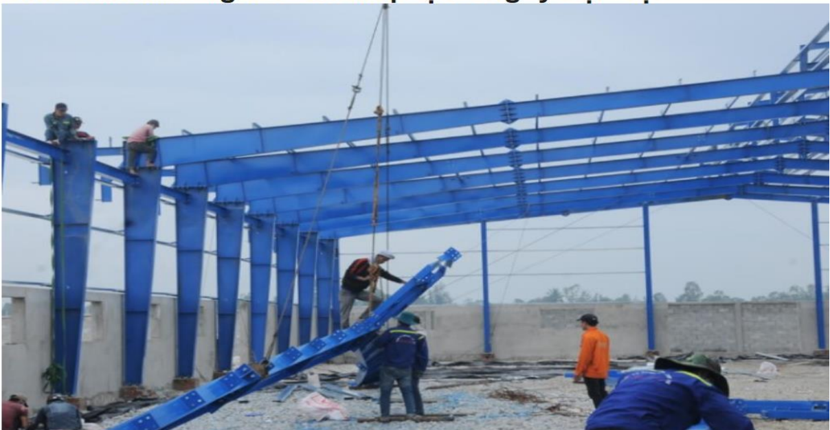
Hình 3. 1: Các công nhân của Công Ty TNHH Thương Mại & Dịch Vụ Kỹ Thuật Đại Việt đang thi công công trình nhà xưởng.
