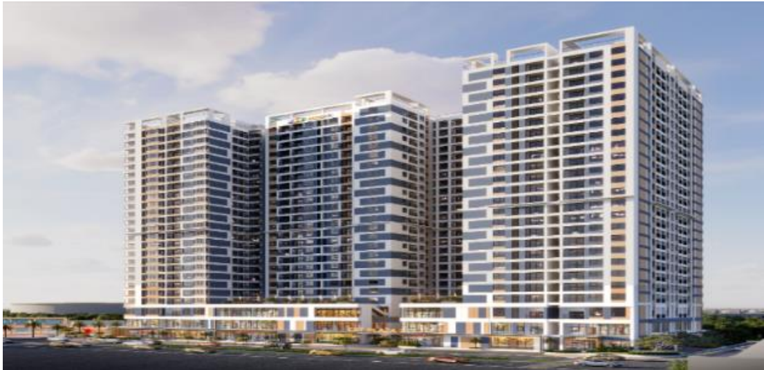
Hình 2.6: Dự án FPT Plaza 3 Đà Nẵng
