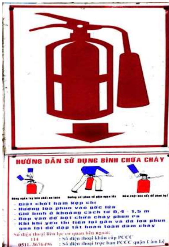
Hình2.9: Biển chỉ dẫn vị trí bình chữa cháy và hướng dẫn sử dụng tại kho
